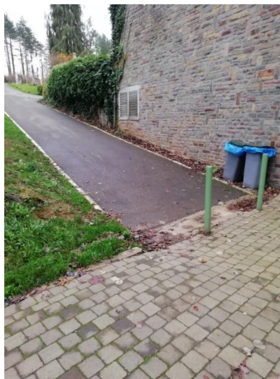
Aan de achterkant van het gebouw
